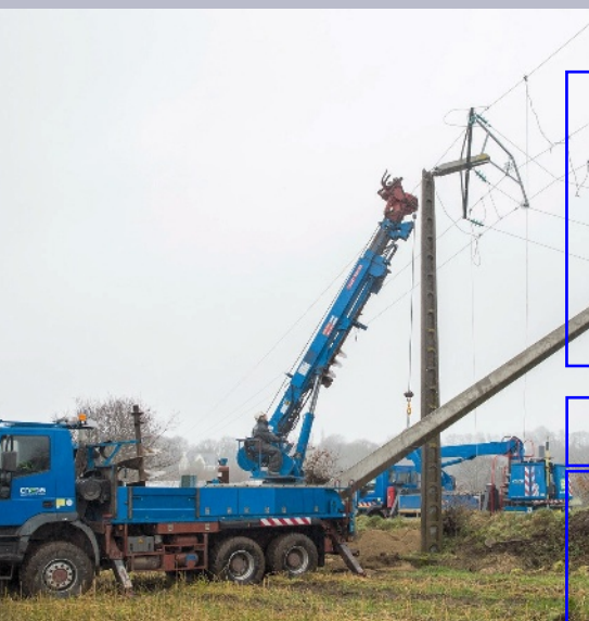
Intervention des équipes Enedis pour rétablir l'électricité dans les foyers à proximité de Quimper, après le passage de la tempête Zeus (mars 2017).
