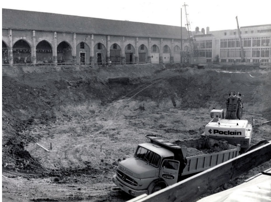
SOUS LE FUTUR PARKING SOUTERRAIN, UN CIMETIÈRE MÉDIÉVAL (ORLÉANS, 1977 À 1979)
